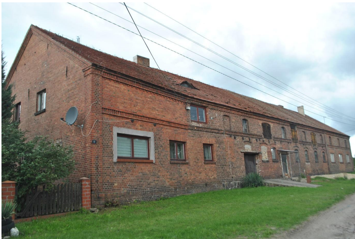
Fot. 1. Budynek mieszkalno-gospodarczy w zespole pałacowo-folwarcznym w Głoguszu; fot. E. A. Marek
