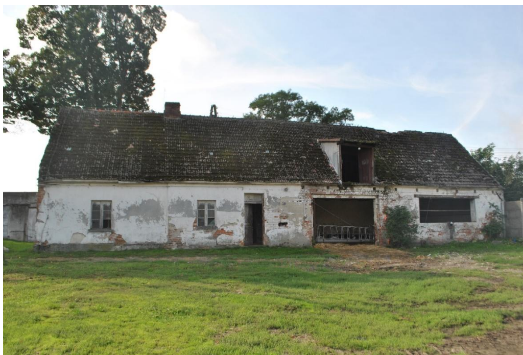
Fot. 2. Dawna oficyna w zespole dworsko-folwarcznym w Kruszyńcu; fot. E. A. Marek
