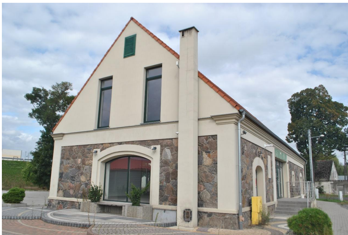
Fot. 14. Dawny spichlerz w zespole dworsko-folwarcznym Gut „A” w Kruszynie; fot. E. A. Marek Budynek inwentarsko-gospodarczy w Obłotnem
